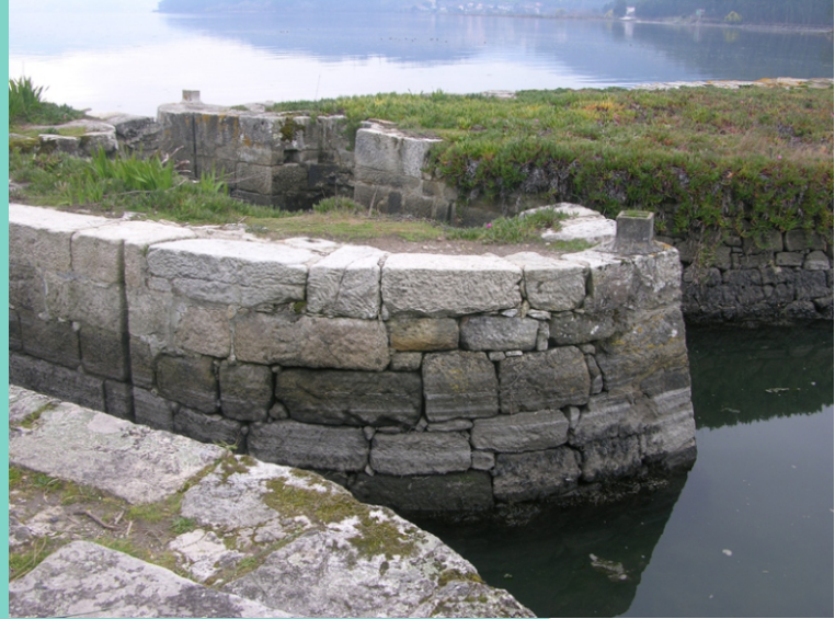
Muros do muíño de marea
